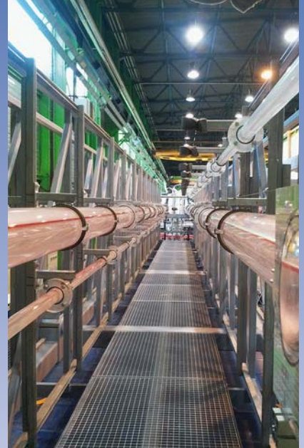
Essai d'un séparateur ionique liquide/liquide pour le champ en eaux profondes réalisé en collaboration avec le Centre technique des industries mécaniques (CETIM) de Nantes.
